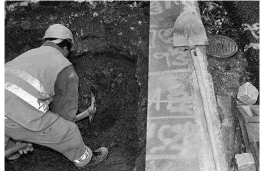
Bild 1: Werkleitungen bei Bedarf sondieren.
