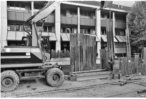
Bild 8: Sicherer Einbau von Spiessen.
