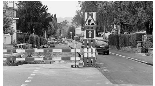
Bild 2: Korrekt signalisierte Baustelle.
