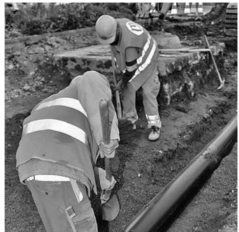
Bild 3: Zur persönlichen Schutzausrüstung gehören Helm, Warnkleider und Schutzschuhe.
