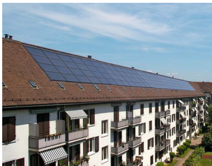
SOLTOP Solartechnik – Installateur SADA – GBM-Genossenschaft + Erdgas Zürich
