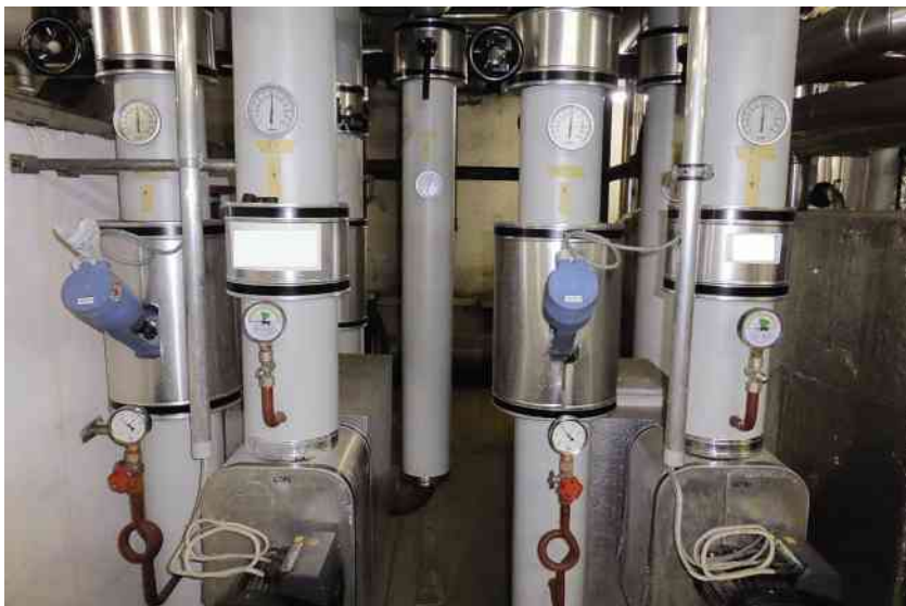
Blick auf die Übergabestation in einem Hotel mit zwei gleich grossen Plattenwärmeübertragern.
